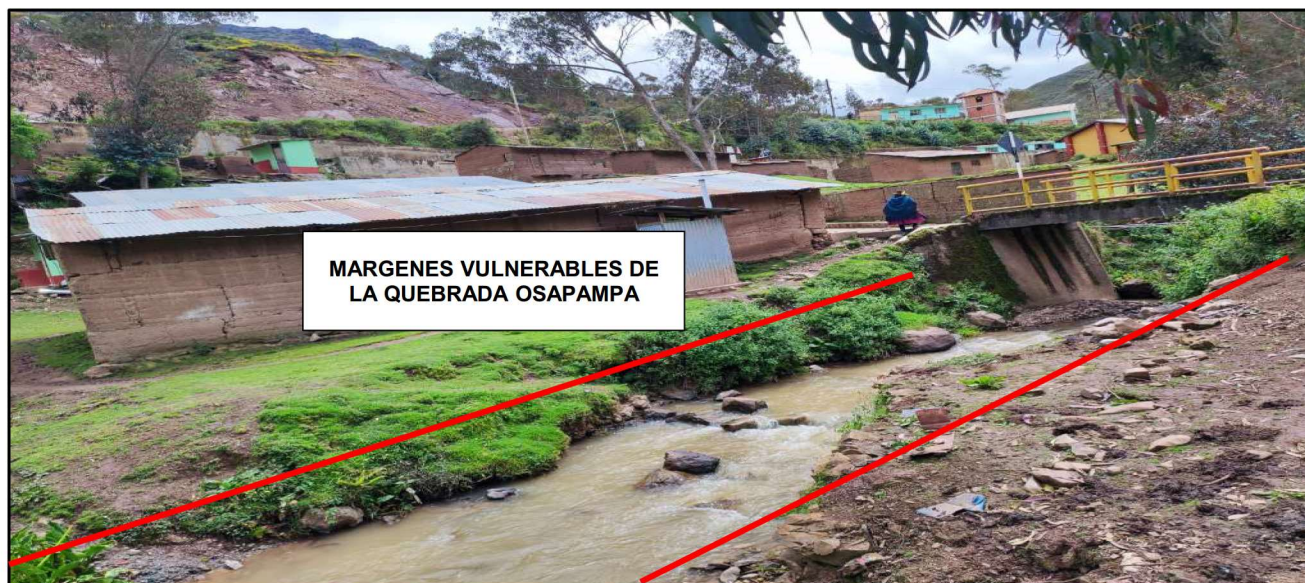
FIGURA N°01: TRAMO CRÍTICO EN EL TRAMO DEMOMINADO PUENTE CHASQUI EN LA QUEBRADA OSAPAMPA
